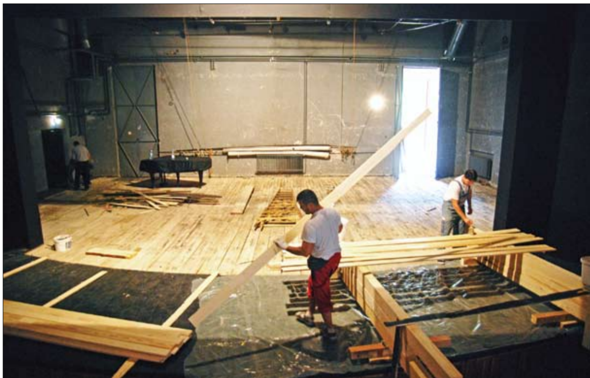
Munkások dolgoznak a színpad bővítésén. Növekvő játékfelület
